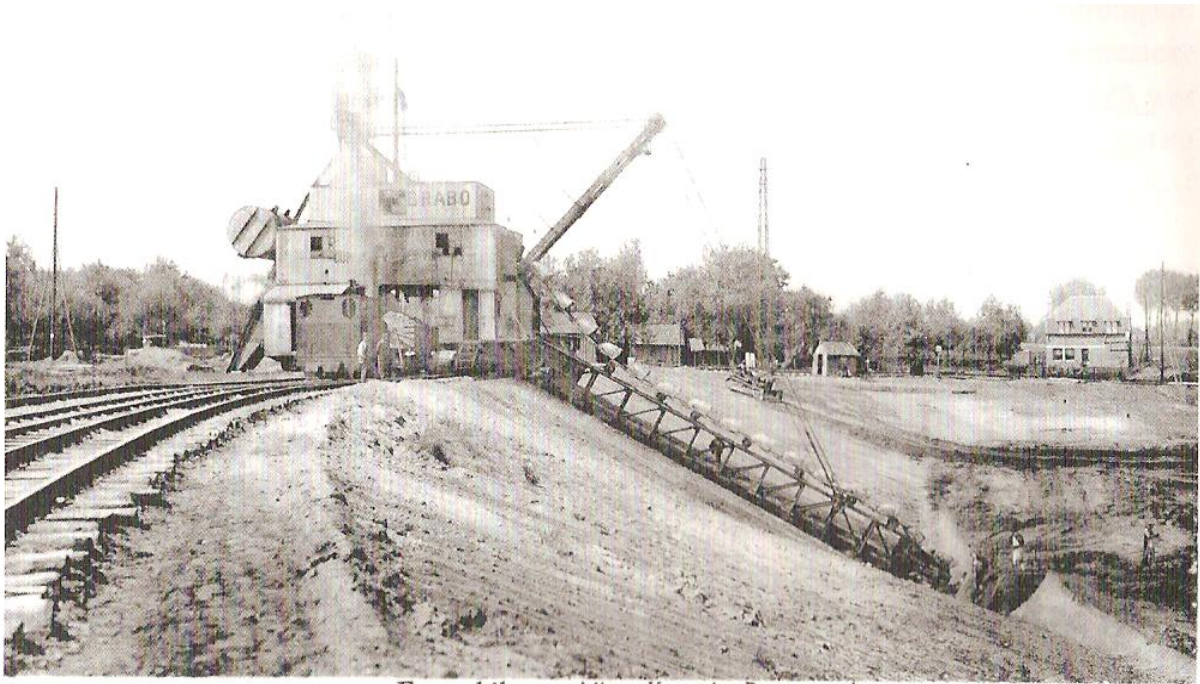
Eygenbilsen Albert Kanaal - Baggerwerk
